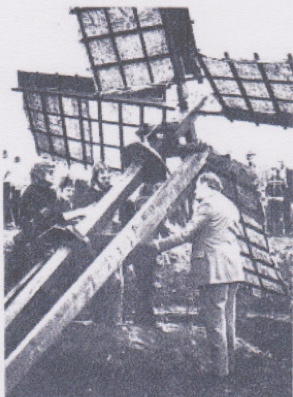
De heer Bokma verricht de ingebruikstelling (Foto: G.D. Wijnja)
